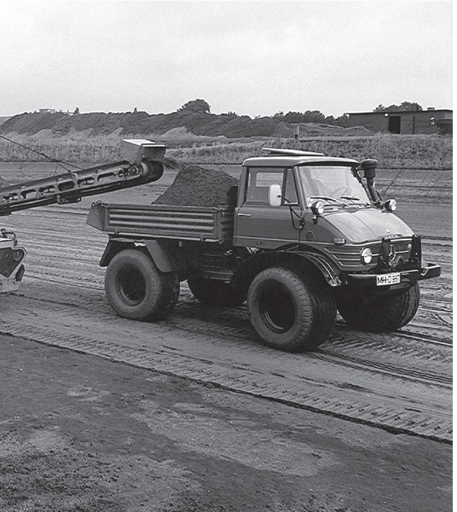
Reinigung der Sandfilterbecken im Wasserwerk Mülheim-Styrum der RWW, um 1974
