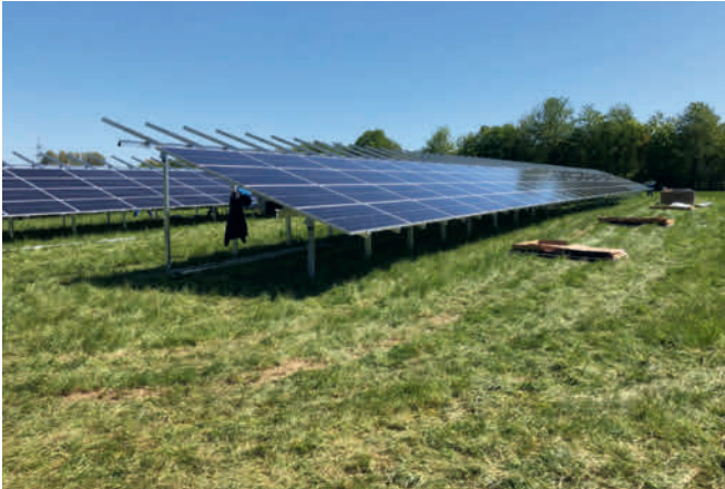
Bild 20.4: Montage der Module Fig. 20.4: Assembly of the modules
