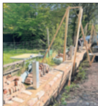
Der Wiederaufbau der Friedhofsmauer Bedburdyck ist gestartet. Foto: Stadt Jüchen
