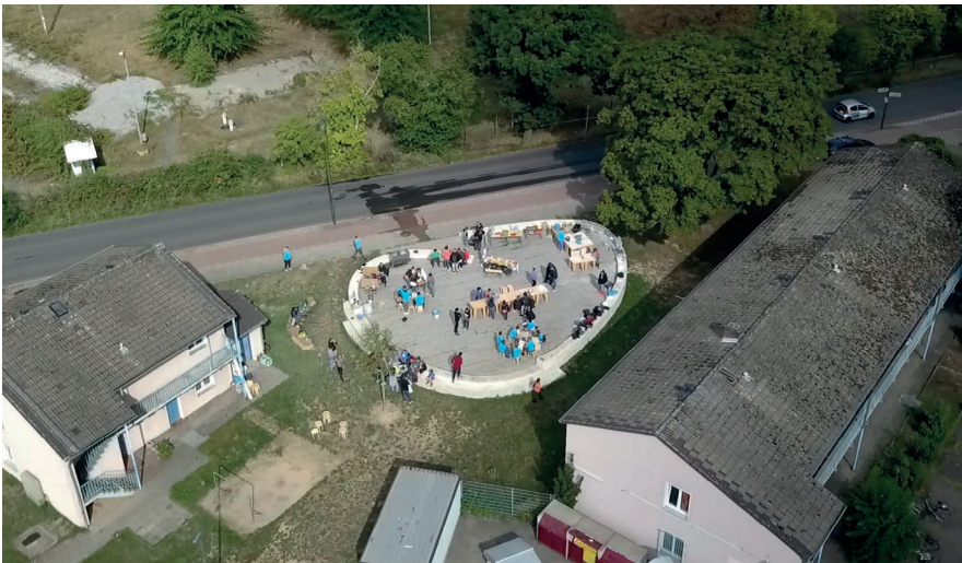
Die Bodenplatte des zukünftigen Wiesencafés, 2019. Drohnenaufnahme: Patrick Kruse
