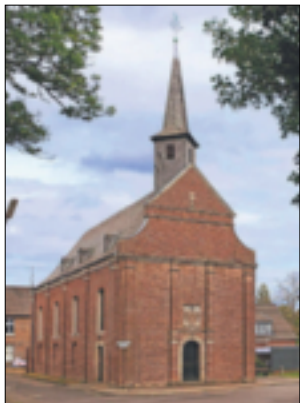
Die Pfarrkirche St. Georg Neuenhoven. Foto: Archiv
