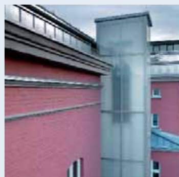
Fahrstuhl einbau im Josephinenhaus
