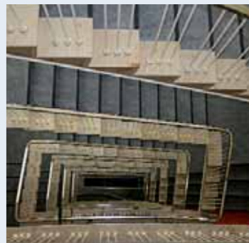
Finanzamt Wuppertal-Elberfeld, Treppenhaus
