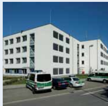
Prototyp für vergleichbare Bauvorhaben der Polizei NRW
