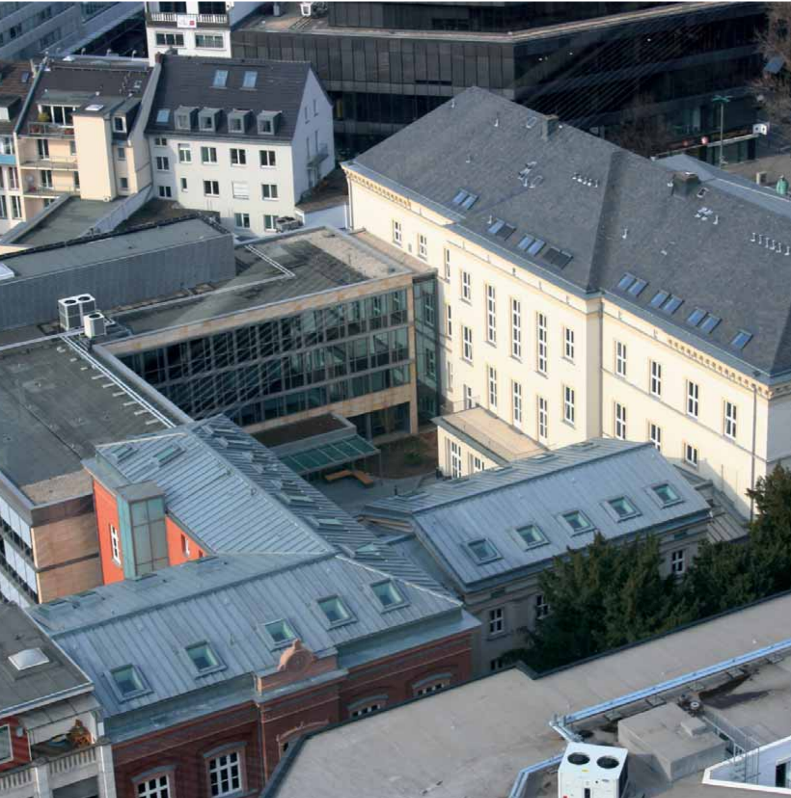
Übersicht über das Gebäudeensemble
