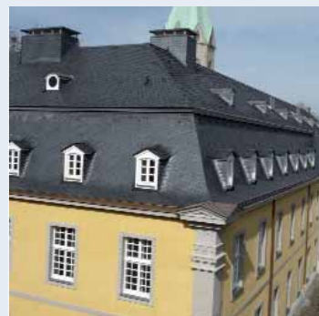
Folkwang Hochschule unmittelbar nach dem Brand und nach der Sanierung des Brandschadens
