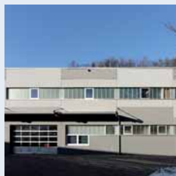
Werkhalle des offenen Vollzugs
