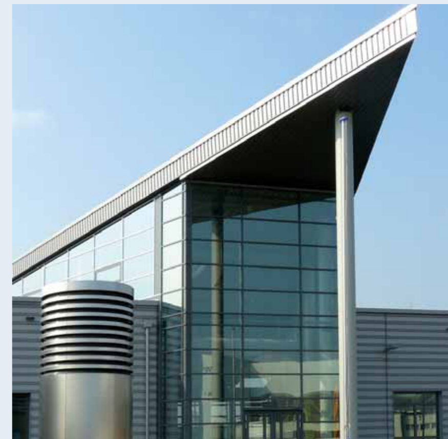
Flugabfertigungsgebäude in der Flugbereitschaft des BMVg in Köln-Wahn
