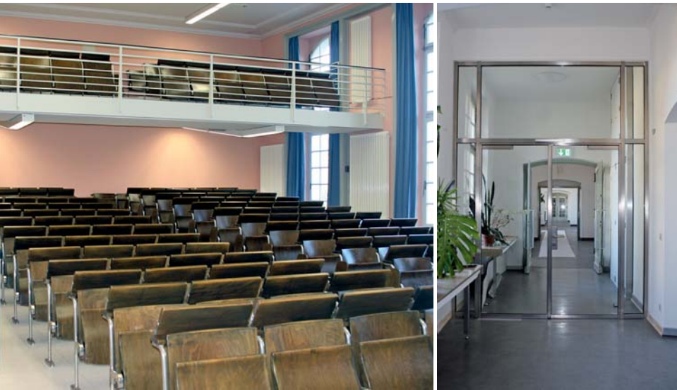
Gute Beispiele für gelungenen Brand- und Denkmalschutz: Der ehemalige Krönungssaal erhielt eine neue Fluchttreppe und einen „fürstlichen“ Anstrich. Die neuen Brandschutztüren beeinträchtigen die Optik der langen Schlossflure so gut wie gar nicht. Fotos: T. Tintelot
