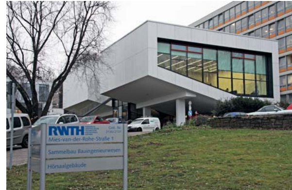
Die beiden Hörsäle der Bauingenieure erhielten eine neu gedämmte Fassade aus Textilbeton. Foto: M. Lux
