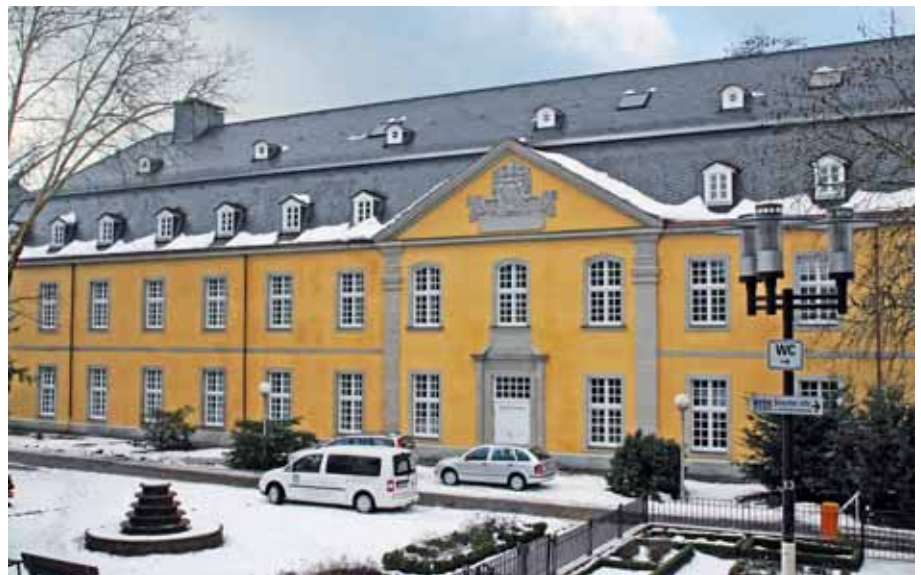
Vollständig wiederhergestellt ist das Dach des Folkwang-Ostflügels auf dem Campus in Essen-Werden. Im Spitzboden mit den kleinen Dachfenstern wurden Computerräume eingerichtet.
