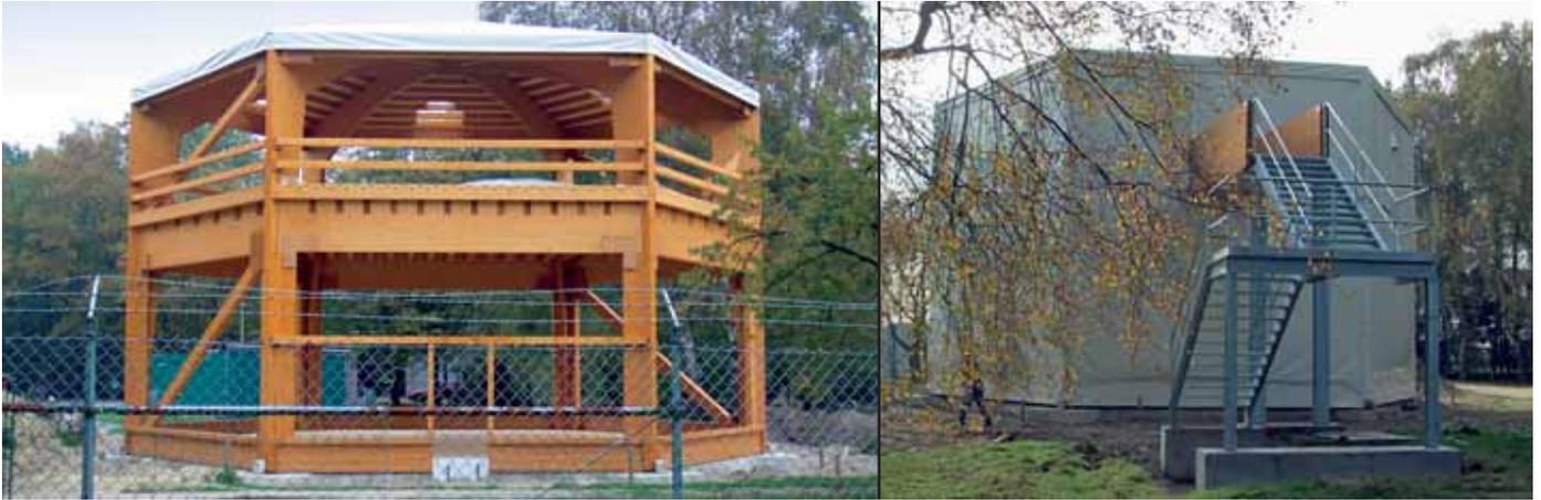
**Die Aufgabe war komplex, die eingesetzten Techniken hochmodern. Und doch mögen sich die Bauarbeiter bei der Errichtung der Bohrlochdetektion in Hünxe in die Steinzeit zurückversetzt gefühlt haben, denn sie durften dort kein Metall verwenden. Schon ein einziges Gramm hätte die neue Ausbildungsstätte, in der der Kampfmittelbeseitigungsdienst NRW das Orten metallhaltiger Munition trainiert, unbrauchbar gemacht.**
