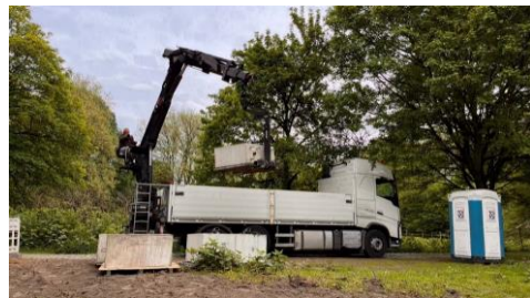
Entladung mit Kran
