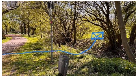
Die geplante Unterquerung des Vonderngrabens inklusive des Aufstellungsortes für den neuen Stromverteilerschrank
