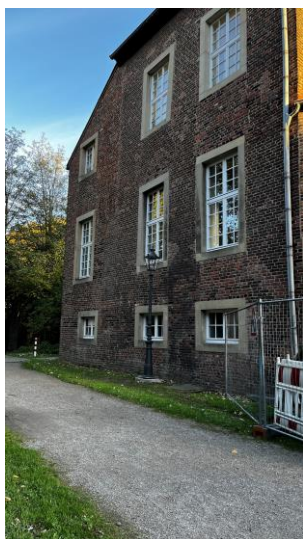
Blick auf die Nordwand des Herrenhauses
