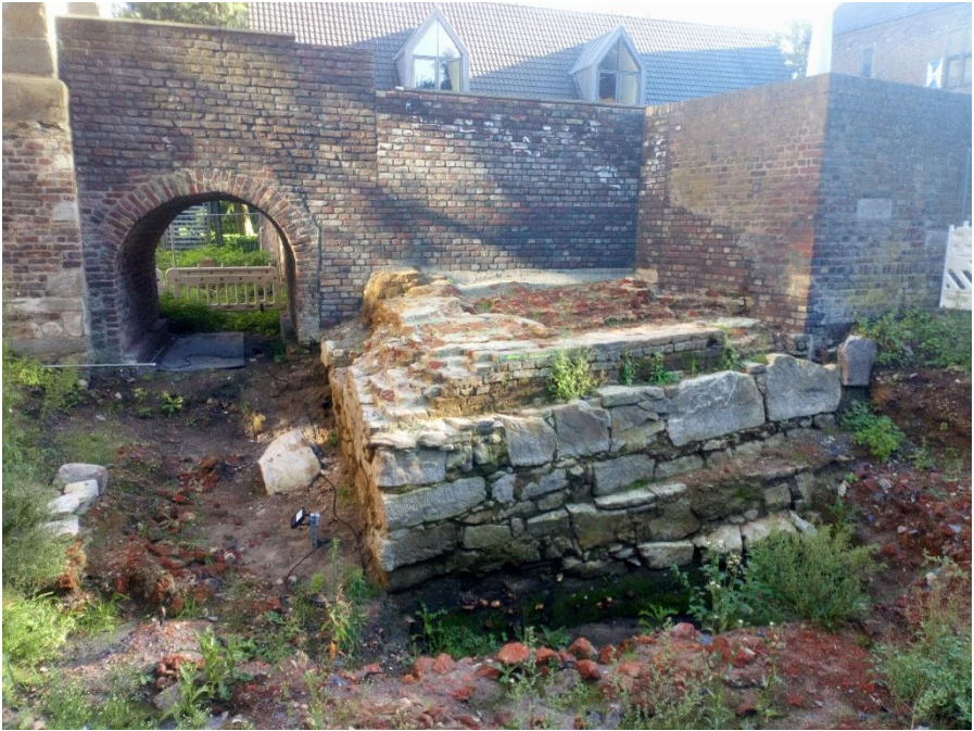
Fundament-Reste an der Stelle der alten Fluchttreppe. Über den Fundamenten der ehemalige, nun geschlossene Zugang zum Burghof.
