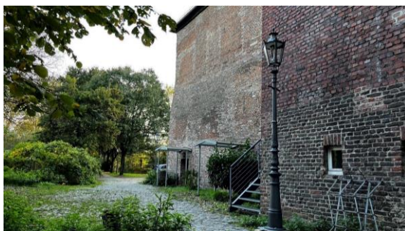
Eine neue Laterne beleuchtet nun auch den Stahltreppenzugang zum Herrenhaus.
