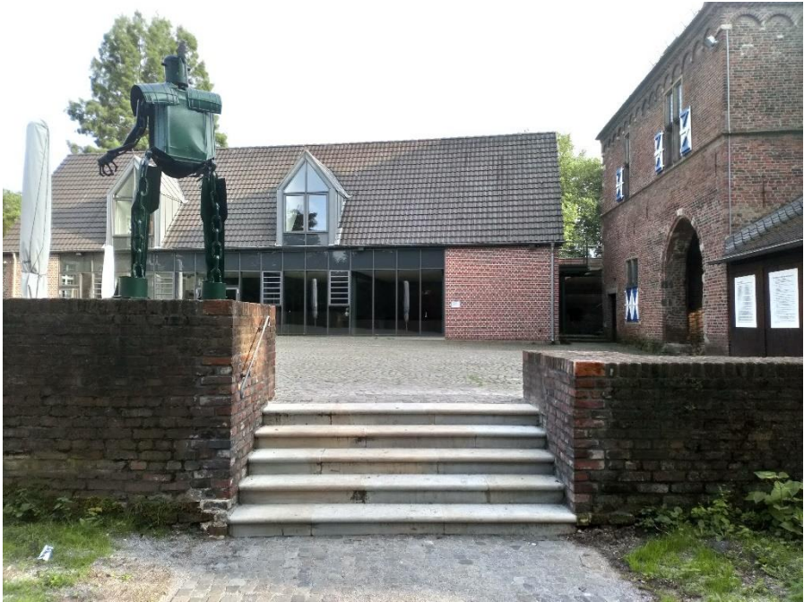
Die neue Treppe an der Nordseite der Burg
