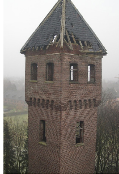
Der Heimatverein hat sich für die Renovierung des zum Teil verfallenen Wasserturms eingesetzt. Foto: Heimatverein Norf
