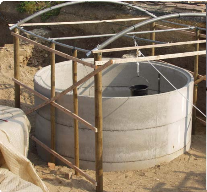
Abb. 51: Verbau mit Betonringen
