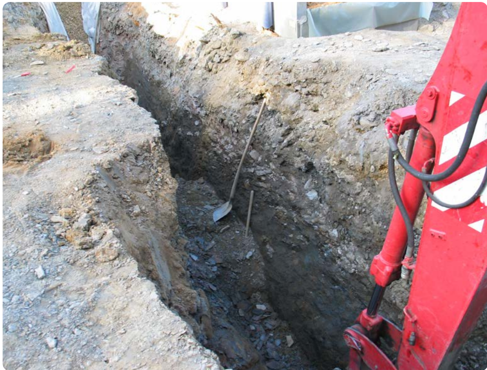
Abb. 34: Abgerutschter Schnitt, Foto: Roger Brandkamp, SVLFG
