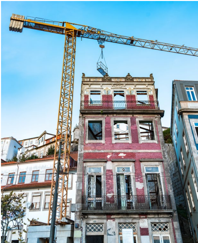
Rückbau einer Problemimmobilie
