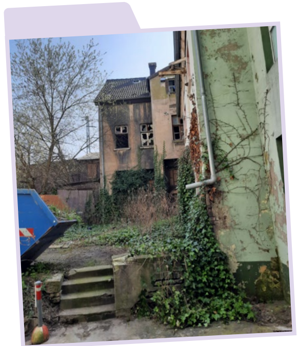
Das Gebäude Wehringhauser Straße 61 (Blick in den Hinterhof) konnte aufgrund einer erfolgreichen Klage nicht über das Vorkaufsrecht erworben werden, ist aber inzwischen freihändig von der HEG angekauft worden.
