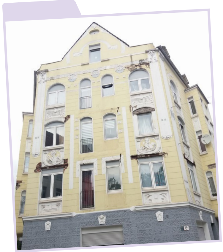
Durch Ansprache wurden Sanierungsmaßnahmen in einem Gründerzeitgebäude in der Dortmunder Nordstadt initiiert
