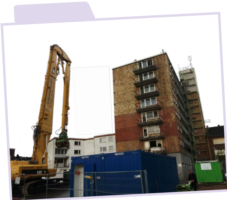
Rückbau einer Problemimmobilie in Hamm
