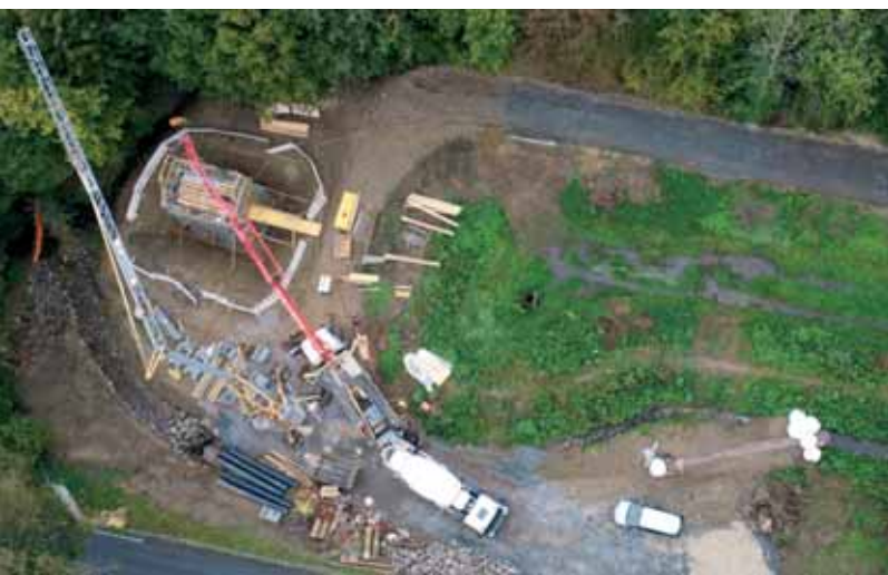
Baustelle Winterhagen West
