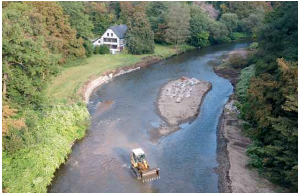
Ufersicherung am Balkhauser Kotten
