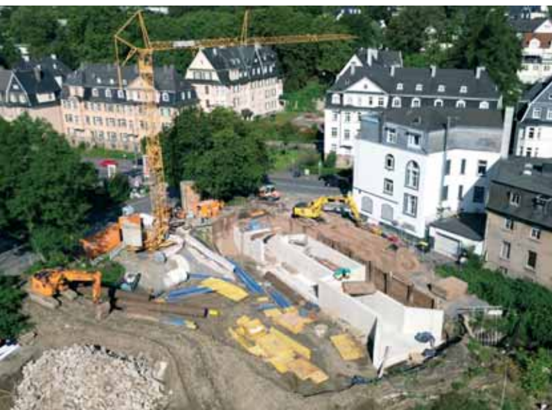
Baustelle Bornberg am Mirker Bach
