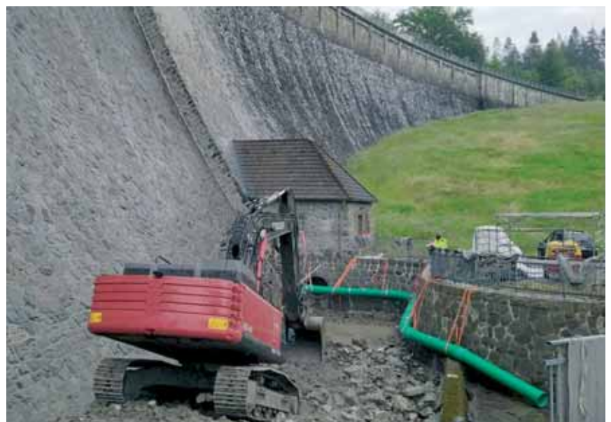
Kerspe-Talsperre: Abbrucharbeiten am Tosbecken
