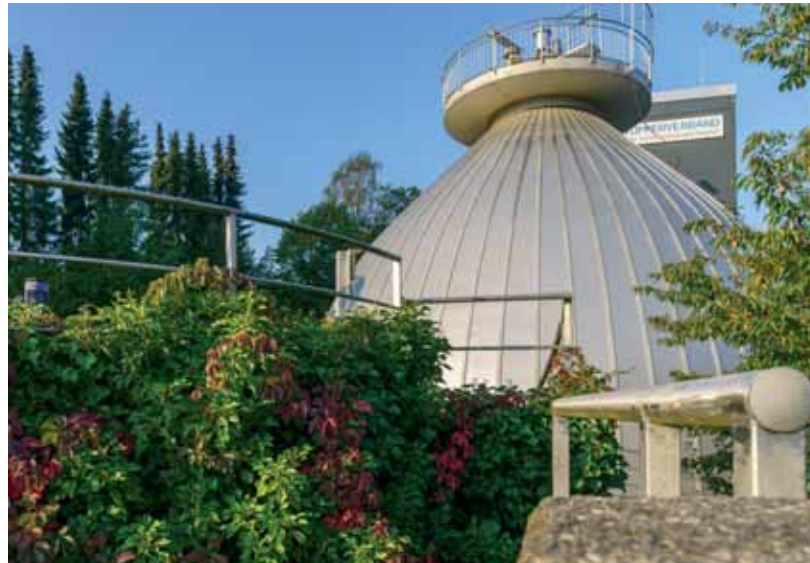
Kläranlage Hückeswagen, Faulbehälter
