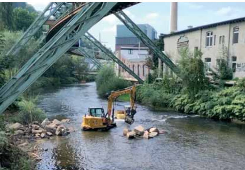
Wupper am Bayer-Werksgelände
