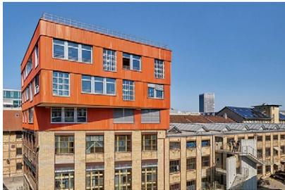
Im schweizerischen Winterthur wurde das K.118 (Kopfbau Halle 118) von baubüro in situ in Zusammenarbeit mit Zirkular, dem Fachplanungsbüro für das Bauen im Kreislauf, aufgestockt. Mit fast ausschließlich schon einmal verwendeten Bauteilen. So wurden 60 Prozent an CO<sub>2</sub> eingespart. In der Schweiz ist das Einbauen alter Bauteile rechtlich einfacher.
