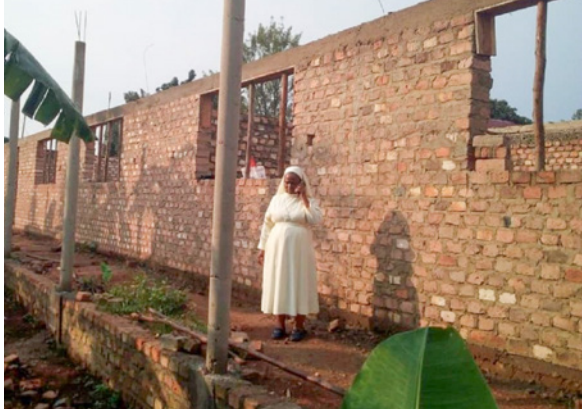
Bau des Männerkrankenhauses (Fertigstellung noch in 2023). Finanziert durch den Verein Menschenbrücke.
