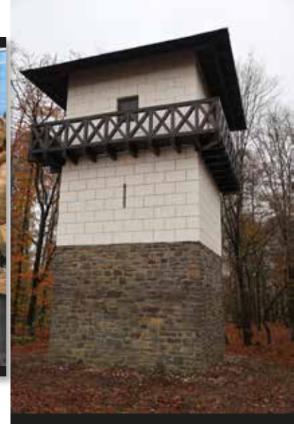
06.12.2023 – Römischer Wachturm instand gesetzt
