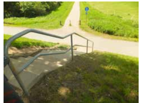
Treppe zum Rheinpark
