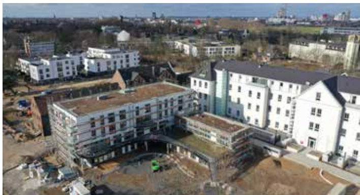
Die neue Kita hinter dem Gesundheitszentrum AP1
