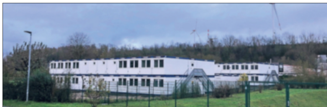
Die Flüchtlings-Container „Am Steelchen“ stehen schon.
