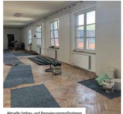
Aktuelle Umbau- und Renovierungsmaßnahmen
