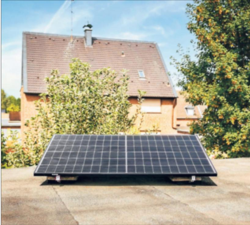
**Mini-Solaranlage mit zwei Modulen und einer maximalen Wechselrichterleistung von 600 Watt: Ein solches System können Hausbesitzer in Eigenregie aufstellen, anmelden müssen sie es allerdings immer beim Netzbetreiber.**
