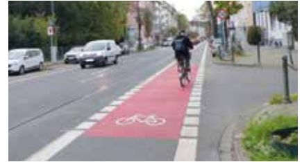
Auf der Bilker Allee sind bisher provisorisch markierte Radfahrstreifen, auf einer Gesamtlänge von rund 1,7 km dauerhaft markiert worden. – Foto: Amt für Verkehrsmanagement
