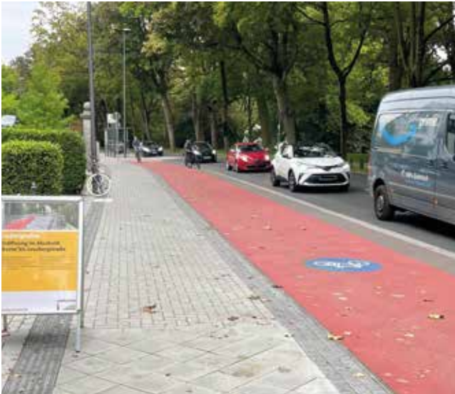
Fertiggestellter 2,30 m breiter Einrichtungradweg an der Ludwigsallee – Foto: Stadt Aachen
