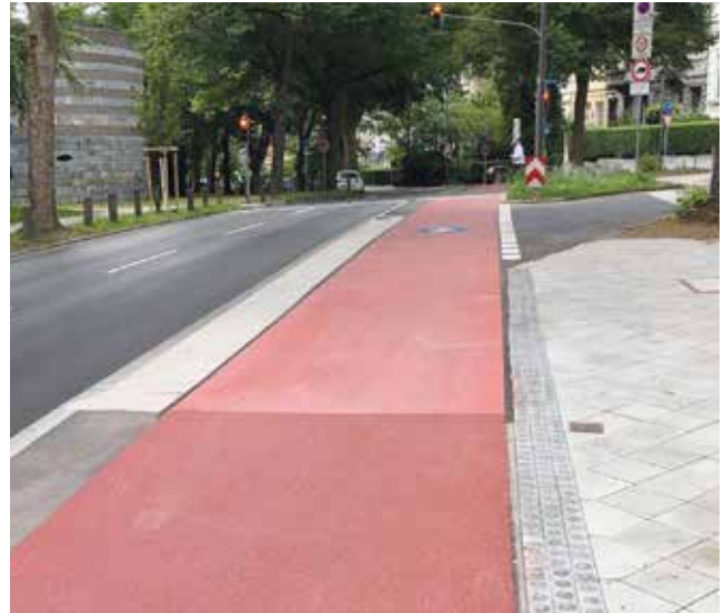
Gestaltung Einmündung Kupferstraße nach Umbau – Foto: Stadt Aachen
