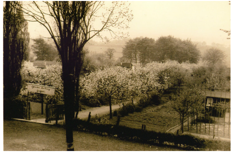
Eingang zur Hatzfelder Kleingartenanlage
