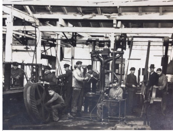
Fabrikhalle der Vluyster Maschinenfabrik Arnold
