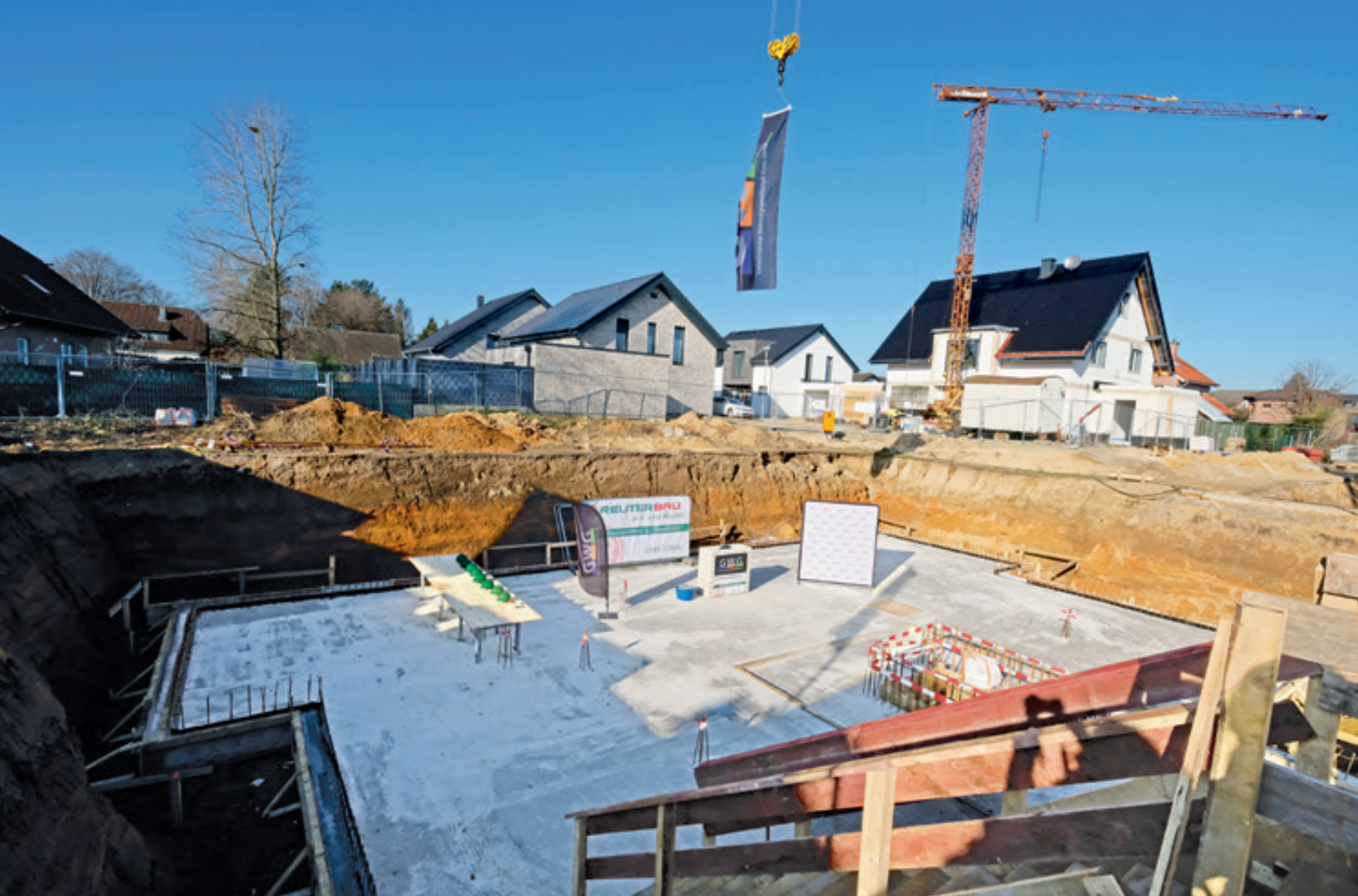
Februar 2023: Die Baustelle bei der Grundsteinlegung
