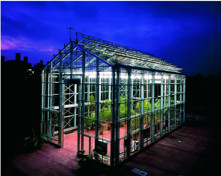
Planung und Finanzierung des Gewächshauses: Bau- und Liegenschaftsbetriebe Nordrhein-Westfalen, Niederlassung Düsseldorf; Foto: Michael Reisch, Düsseldorf.
