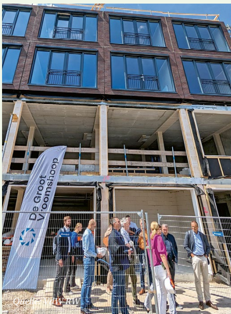
Zwei Grundgeschosse in klassischer Bauweise können bis zu sieben aufeinandergestapelte Module tragen
