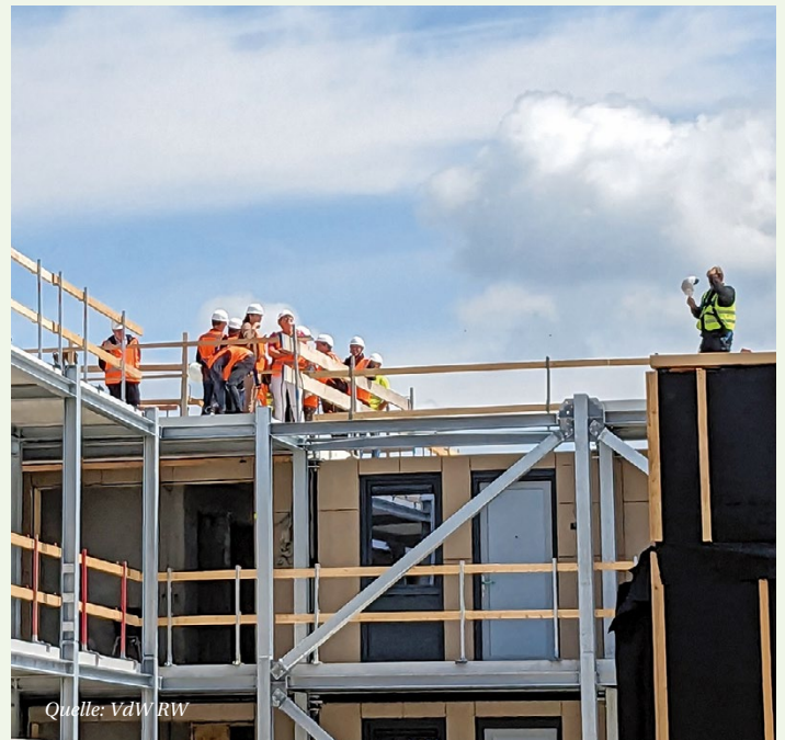
In nur zwei Tagen gelingt es dem Unternehmen aus der CTP-Holzplatte eine ganze Wohnung zusammenzusetzen. Für die Montage benötigt das Bauunternehmen eine Woche pro Etage
