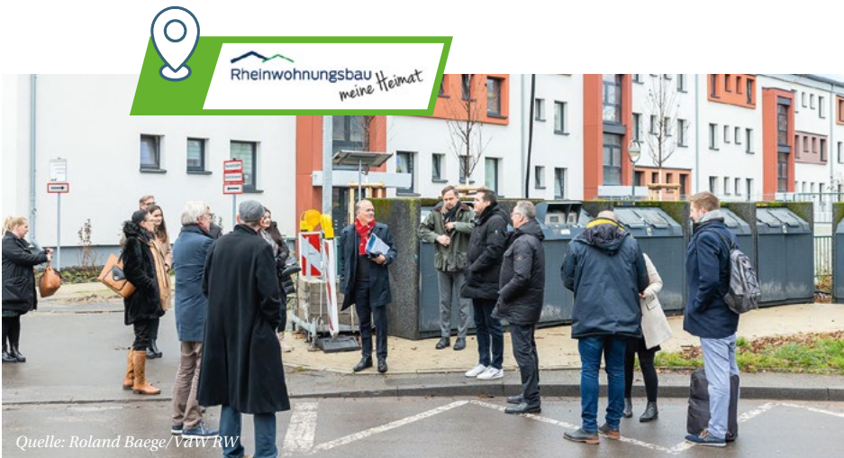
In Düsseldorf-Garath läuft derzeit die energetische Modernisierung von 132 Wohnungen mit Aufstockung des Wohnquartiers der Rheinwohnungsbau
