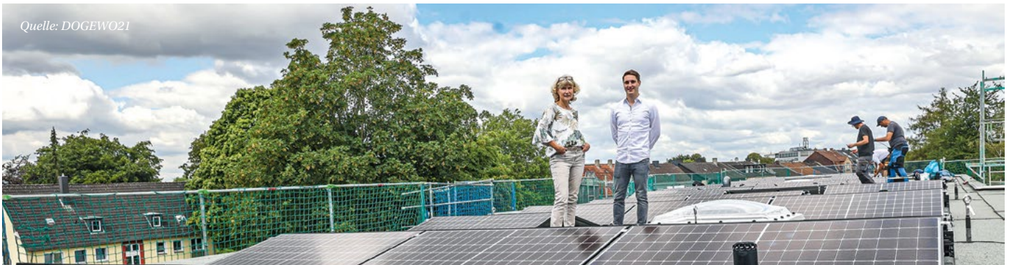
Wiltrud Grünebaum, Abteilungsleiterin Sonderprojekte bei DOGEWO21, und Marc Steinhofer, Projektleiter der DEW21, führen das Mieterstrom-Pilotprojekt gemeinsam aus
