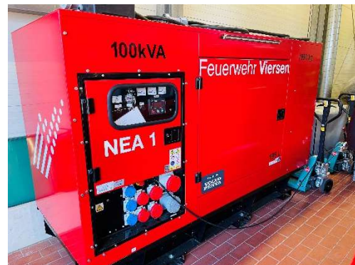
Netzersatzanlage NEA
