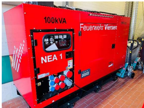
Netzersatzanlage (NEA)
