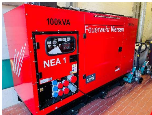
Netzersatzanlage (NEA)
