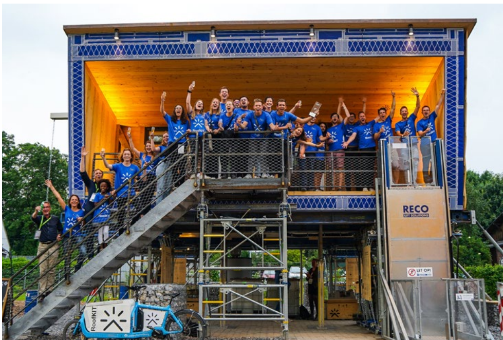
Das Team RoofKIT des Karlsruher Instituts für Technologie gewann den ersten Solar Decathlon in Deutschland. Foto SDE 21/22
