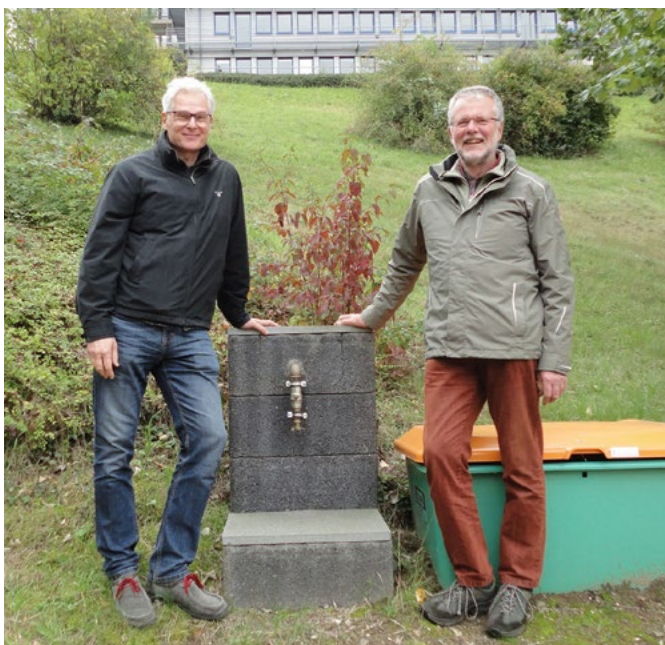
Ulrich Wissemann vom Dezernat für Gebäude-, Sicherheits- und Umweltmanagement (rechts) und Uni-Kanzler Dr. Roland Kischkel vor der neuen Regenwasserzapfstelle auf dem Campus Griffenberg. Foto Gertrud Lohaus
