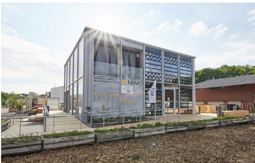
Acht Häuser des SDE 21/22 bleiben für mindestens drei Jahre auf dem Gelände an der Nordbahntrasse in Wuppertal stehen und können besichtigt werden. Foto Marvin Hillebrand
