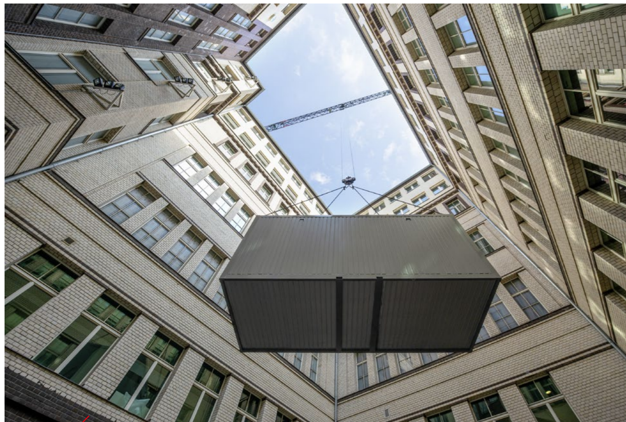
Aufwendige Sanierungsmaßnahmen im Behrensbau vor der Einrichtung der Jubiläumsausstellung
