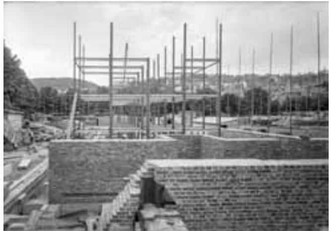
Abb. 1: Bauzustand des preußischen Staatsarchivs Marburg am 19. Mai 1936. Ein Blick von Süden auf den westlichen Magazintrakt (heute Richtung Friedrichstraße): das Stahlskelett ist bis auf die Höhe des vierten Geschosses erstellt, das umgebende Ziegelmauerwerk bis auf die Höhe des ersten Geschosses = Erdgeschoss (Quelle: Deutsches Dokumentationszentrum für Kunstgeschichte – Bildarchiv Foto Marburg, Aufnahme-Nr. 88.897)
