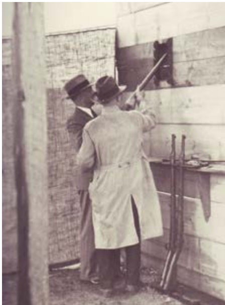
Der Schießstand in den 1930er Jahren verfügte bereits über eine hohe Schutzwand.
