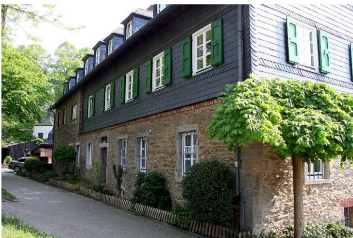
Abb. 6: das Herrenhaus blieb erhalten und wurde 1976 restauriert. Foto 2020
