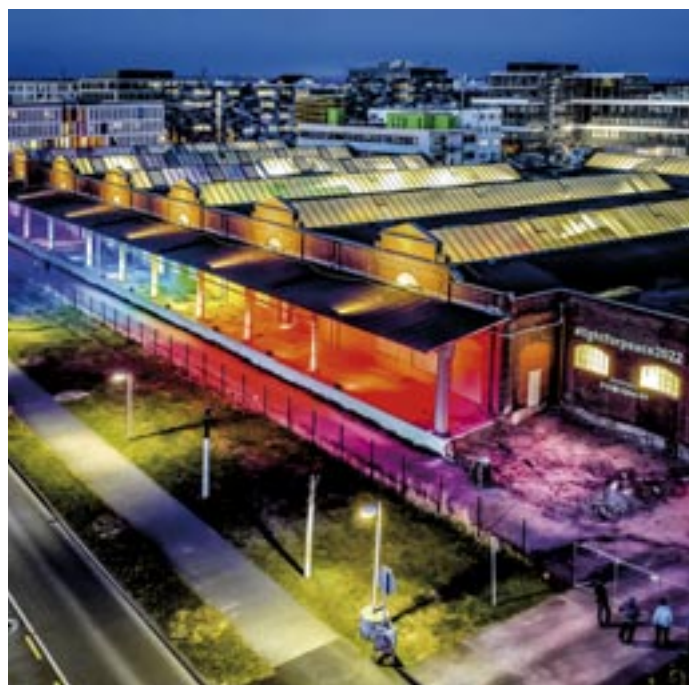
Am Sonntag kann man sich bei Baustellenführungen über den aktuellen Stand der Arbeiten informieren. Foto: Ralph Matzerath
