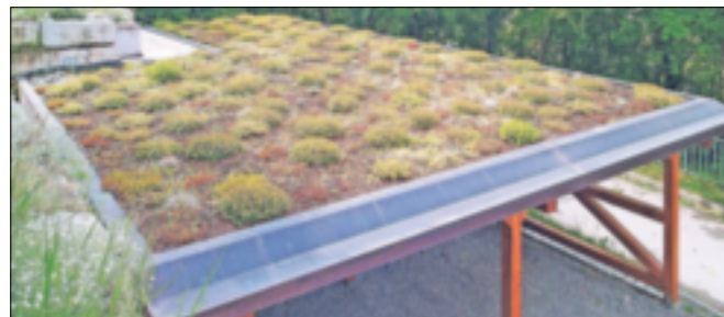
Kleine Dachfläche, große Wirkung: Begrünungen von Carport, Garage oder Gartenhäuschen verbessern das urbane Mikroklima.
