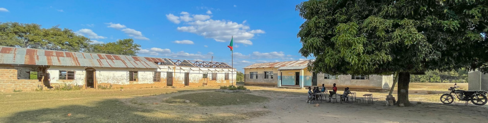
Ein Blick auf die Chiteve Primary School, um die sich Steffi Greuel kümmert. Unterricht findet aktuell unter dem Baum statt, da die Gebäude nicht nutzbar und teilweise einsturzgefährdet sind. Fotos: Steffi Greuel
