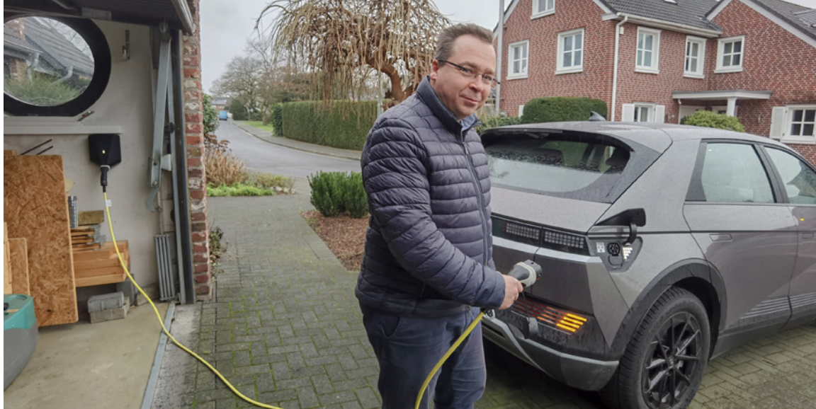
Dirk Steinkamp lädt sein Auto an der heimischen Wall-Box. Doch er kämpft auch für mehr Ladesäulen im öffentlichen Raum. Foto: Thomas Broich
