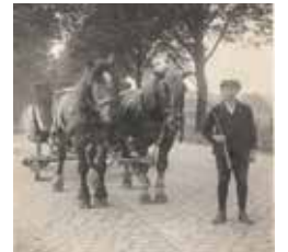
Abb.20 Pferdefuhrwerk für den Rübentransport, um 1930.
