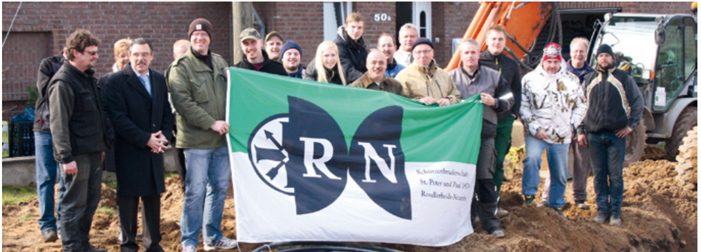
Gruppenfoto nach dem „ersten Spatenstich“ mit dem Vertreter der Sparkasse Neuss, Herrn Karl-Heinz Fassbender, Leiter der Zweigstelle Norf (2. v. li.)
