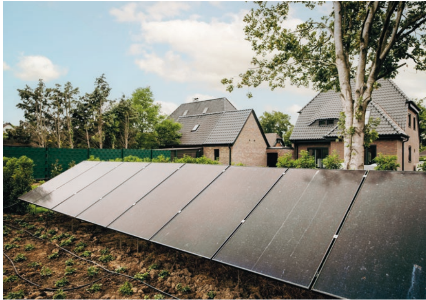
Eine Photovoltaik-Anlage lässt sich nicht nur auf dem Dach, sondern auch freistehend aufbauen, wie etwa im Garten von Thorben Henning.
