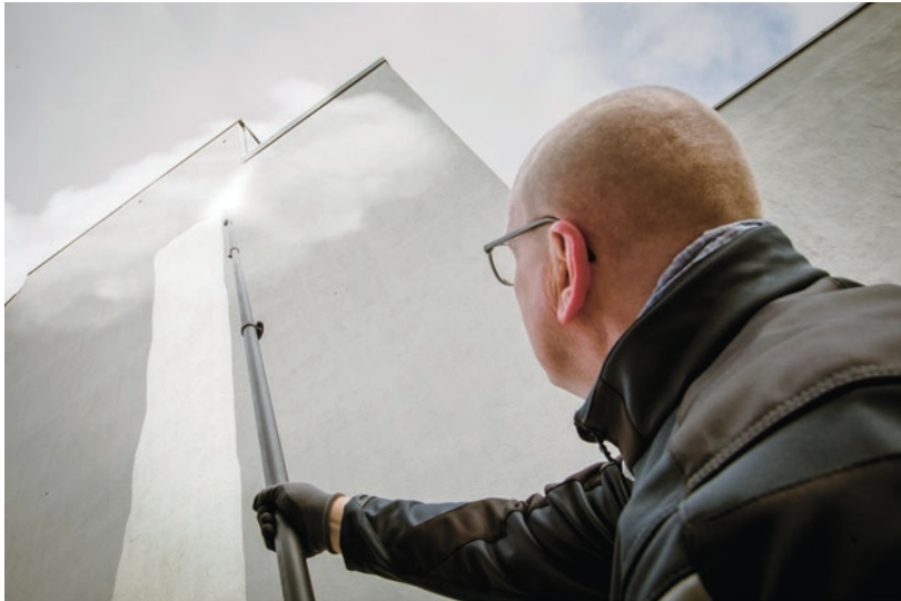
Algen und Ruß bekämpft fassago nach wie vor mit langen Teleskopplanzen und sanfter Spülung.
