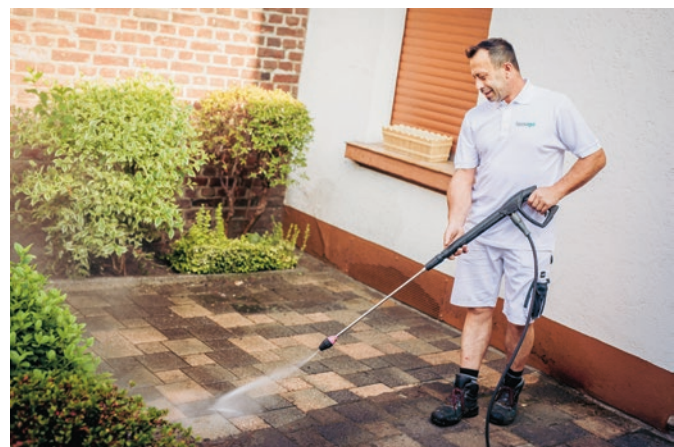
Das fassago-Reinigungsverfahren eignet sich auch zur Reinigung von Dächern und Terrassen.
