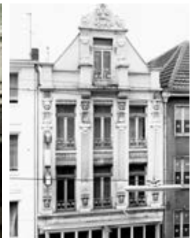
Büchel 44 (Cafe Hellas) mit Jugendstilfassade vor dem Abbruch, 1969 (Stadtarchiv Neuss)
