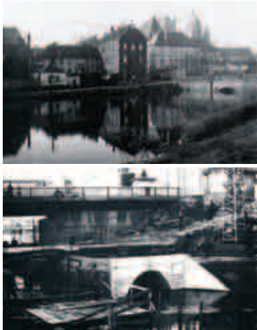
oben: Blick vom Hessentordamm über den Erftkanal zur Hessentorkirche (li.: Hospitalkirche), um 1910, unten: Die Verrohrung des Erftkanals unterhalb der Hessentorbrücke, 1960er Jahre
