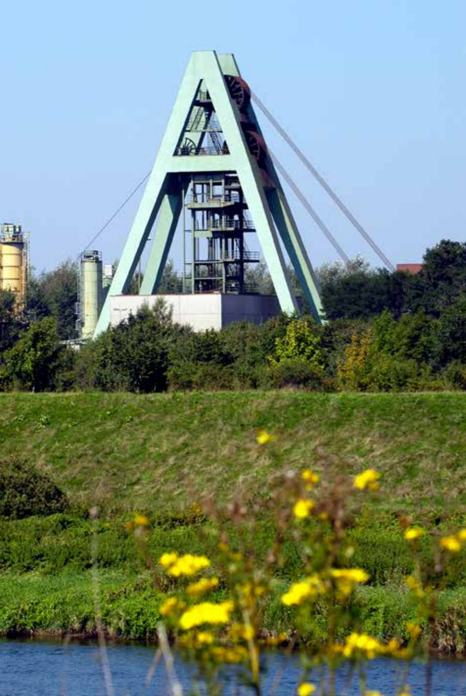
Bergwerk Auguste Victoria/Blumenthal, Schacht 8 in Haltern. Quelle: Deutsche Steinkohle AG
