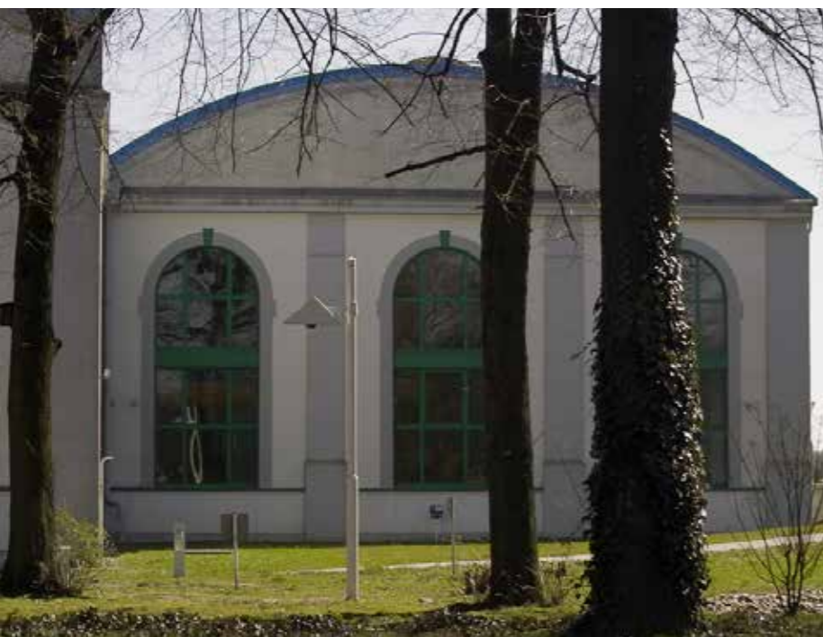
Wasserwerk Haltern. Foto: RIK/Walter
