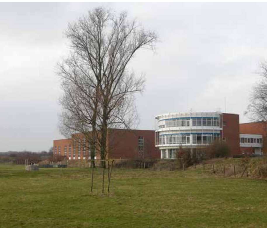
Wasserwerk Dorsten-Holsterhausen. Foto: RIK/Budde
