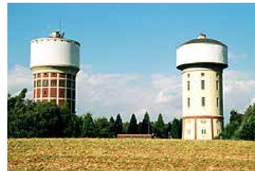
Wassertürme am Hellweg. Foto: RIK/Budde
