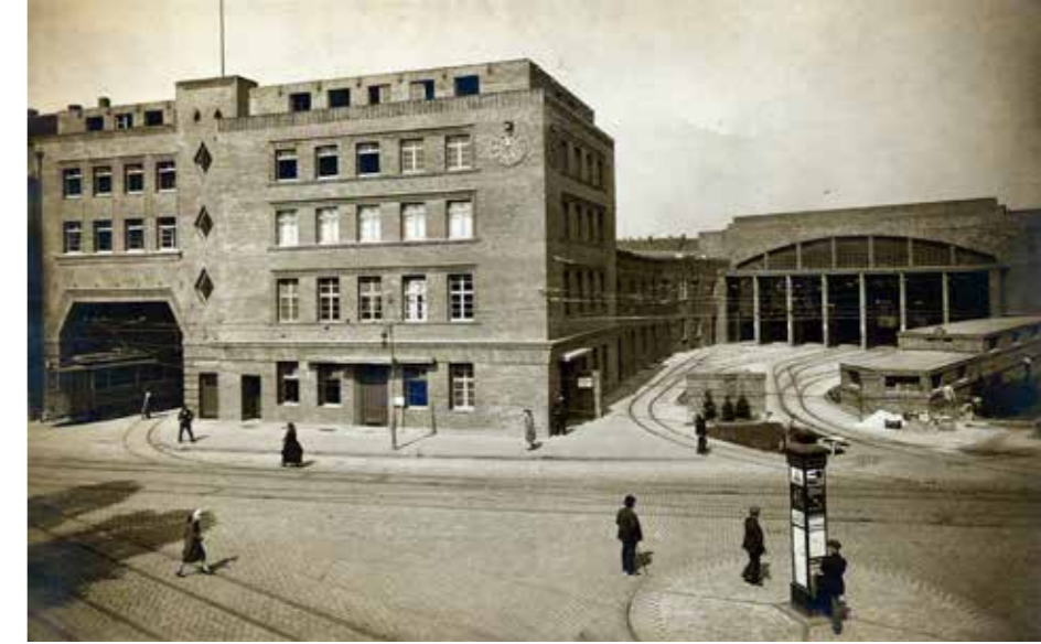
Betriebshof an der Hauptstraße, vermutlich 1920er-Jahre; Quelle: ISG
