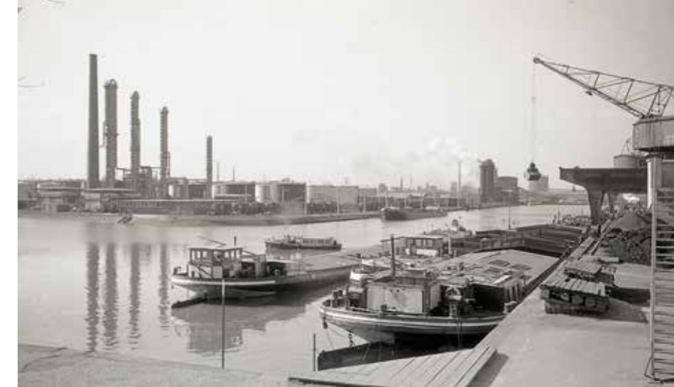
Verladen von Schüttgut im Handelshafen, im Hintergrund der Industriehafen mit dem Großtank- lager der Aral AG 1965; Foto: Werner Nickel, Quelle: ISG
