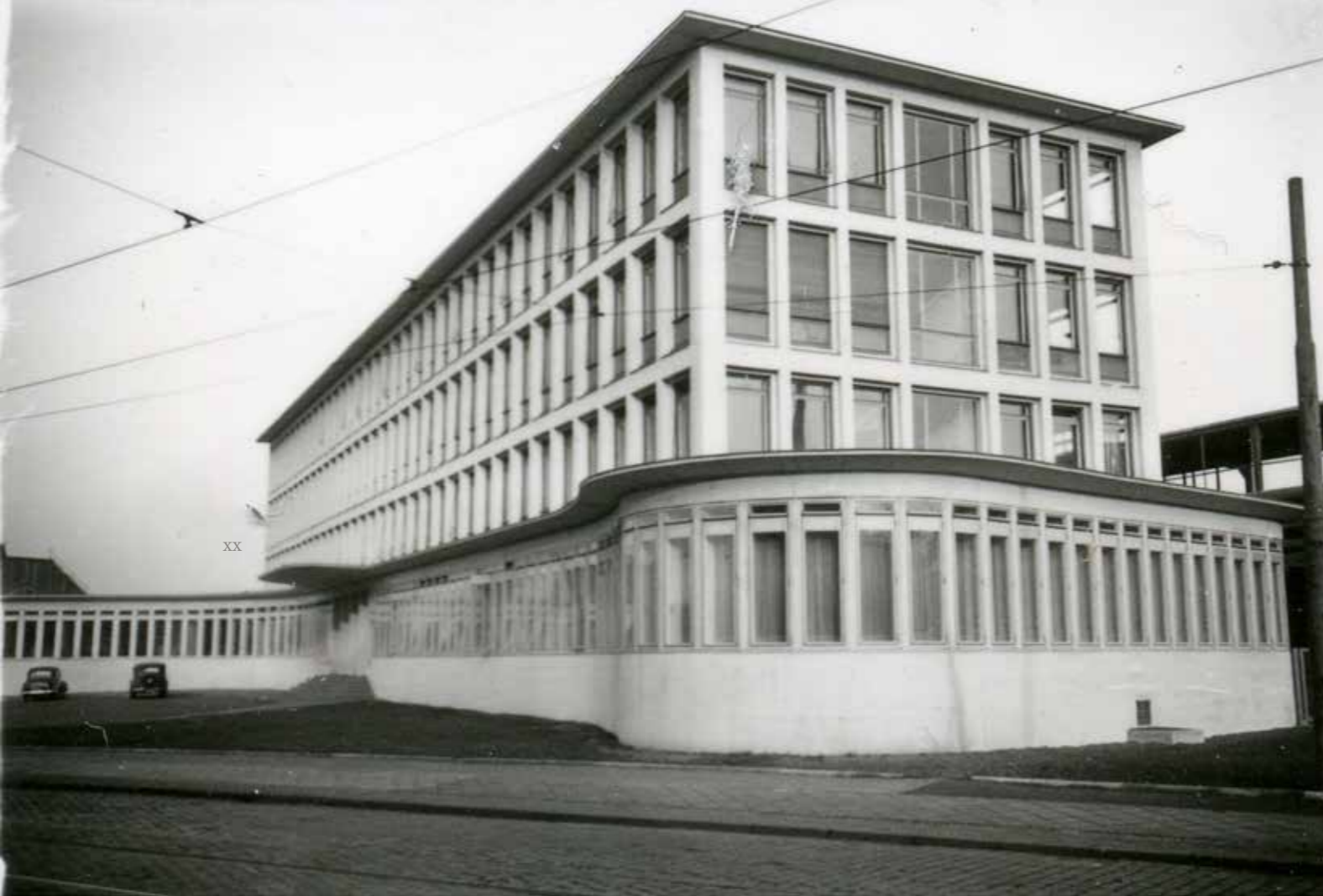
Ehemaliges Verwaltungsgebäude Thyssen-Draht, 1953; Foto: Hans Rotterdam, Quelle: ISG
