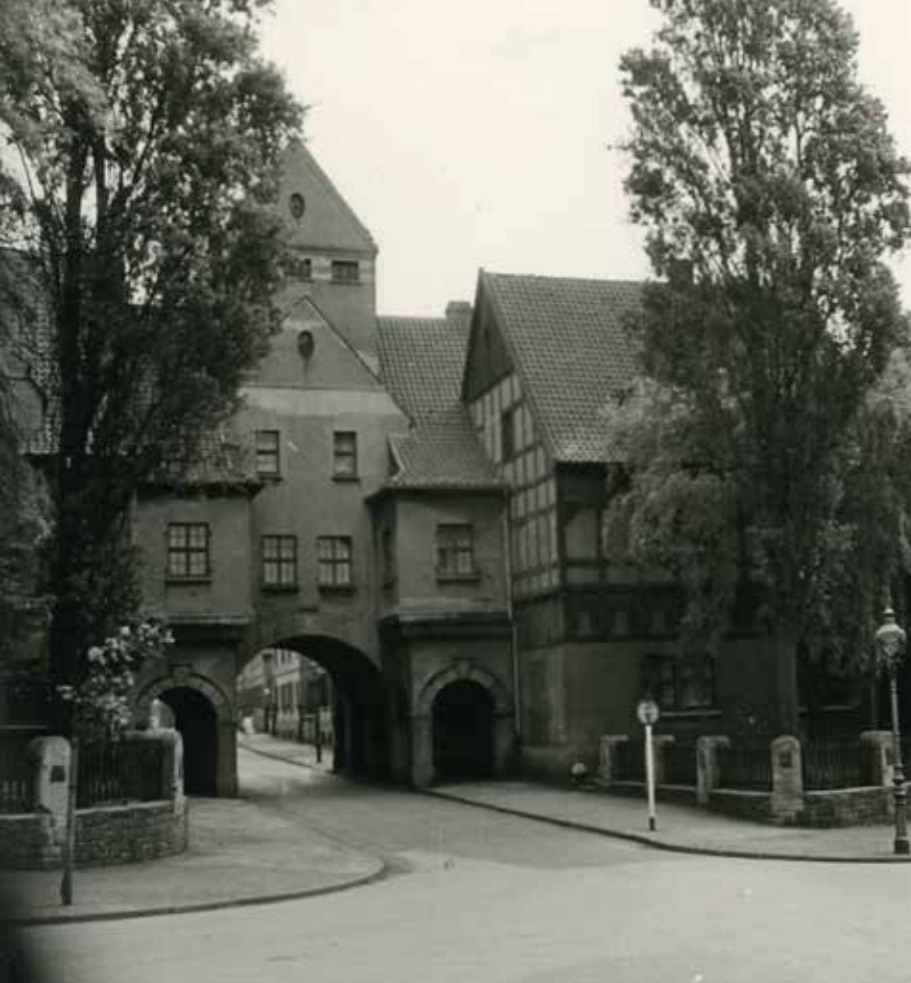
Schievenfeld-Siedlung, Blick auf das Torhaus, 1955; Foto: Hans Rotterdam, Quelle: ISG
