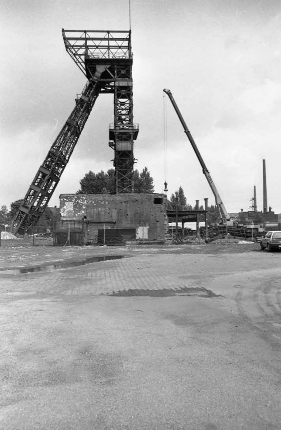
Abbau des Fördergerüsts von Schacht 1 für das LWL-Industriemuseum Dortmund-Zollern 1986; Foto: Alfons Kampert, Quelle: ISG
