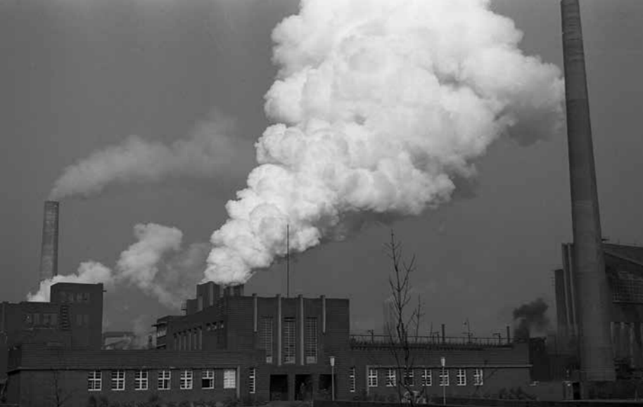
Verwaltungsgebäude der Kokerei Alma, Zeche Rheinelbe, Schacht Alma 1954; Foto: Hans Rotterdam, Quelle: ISG
