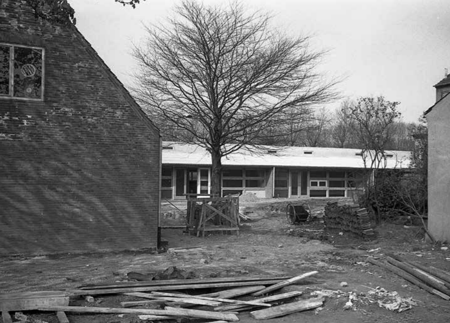
Künstlersiedlung Halfmannshof, Ausstellungshalle im Rohbau 1957; Foto: Hans Rotter- dam, Quelle: ISG
