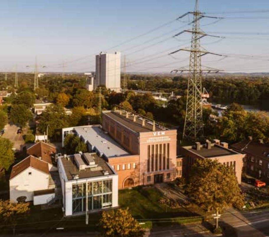
Umspannwerk Recklinghausen. Fotos: RIK/ Staudinger
