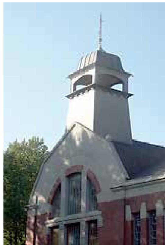
Schacht Oberschuir. Foto: RIK/Walter
