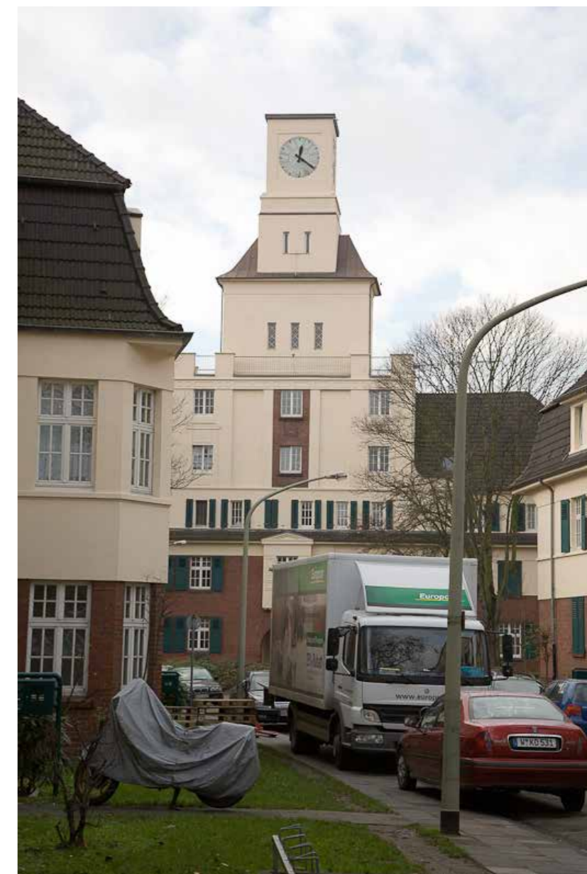
Siedlung Hüttenheim. Foto: RIK/Walter
