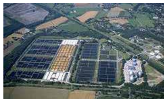
Klärwerk Emschermündung. Quelle: Emschergenossenschaft
