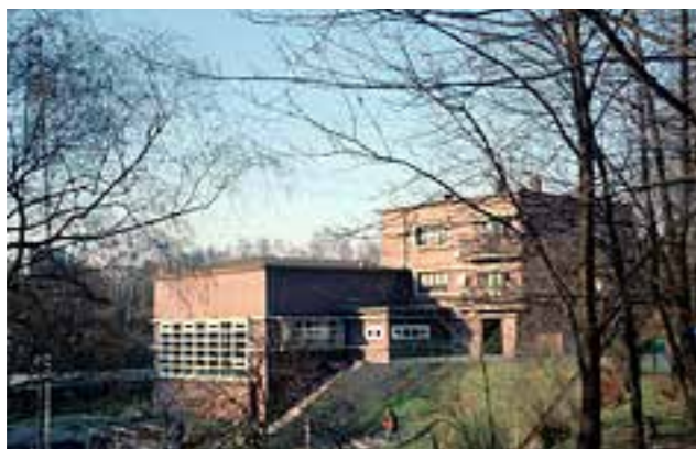
Pumpwerk Schwelgern. Foto: RIK/Walter
