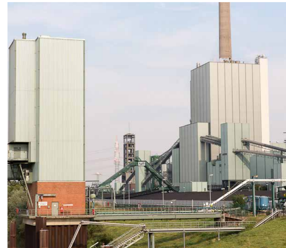
Kraftwerk Walsum. Foto: RIK/Walter
